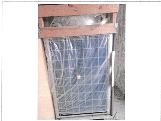
多联式空调系统 (PUHY-P350YRKC-A)
