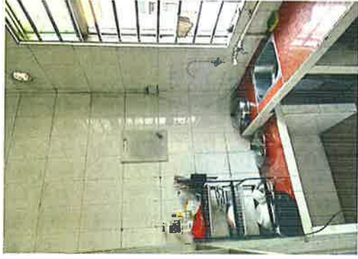
估价对象内部状况
