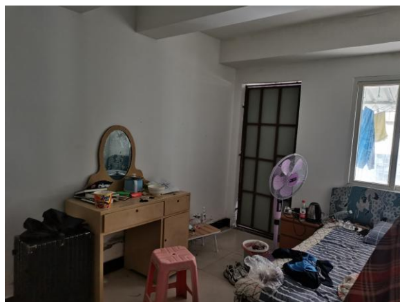
估价对象顶层隔热层内部状况一
