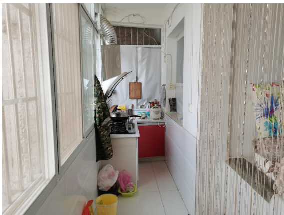
估价对象三楼阳台改装为厨房
