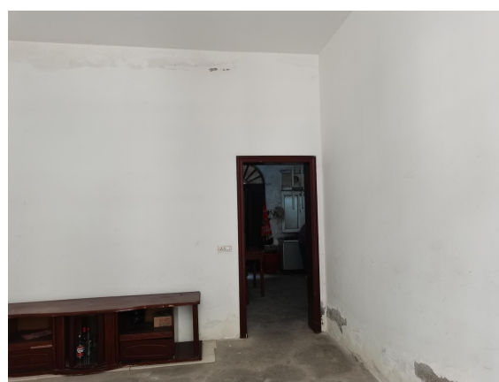
估价对象一楼内部状况一
