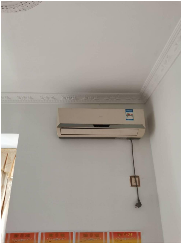
挂式空调现状
