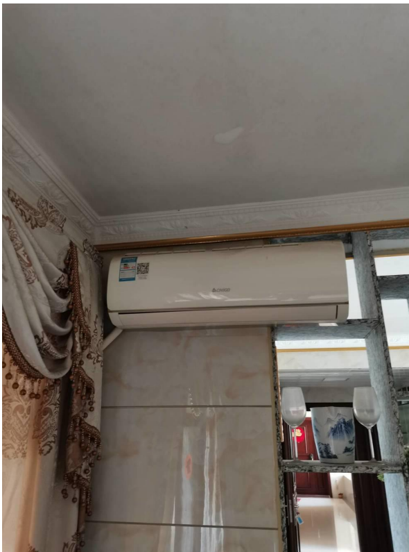
挂式空调现状
