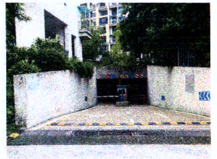
停车场出入口
