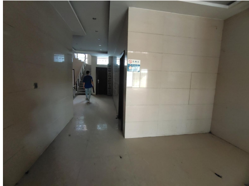
估价对象 S108 内部状况 2
