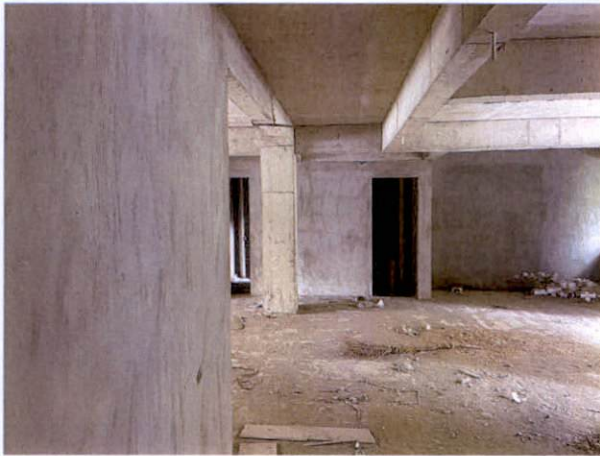
估价对象内部状况一
