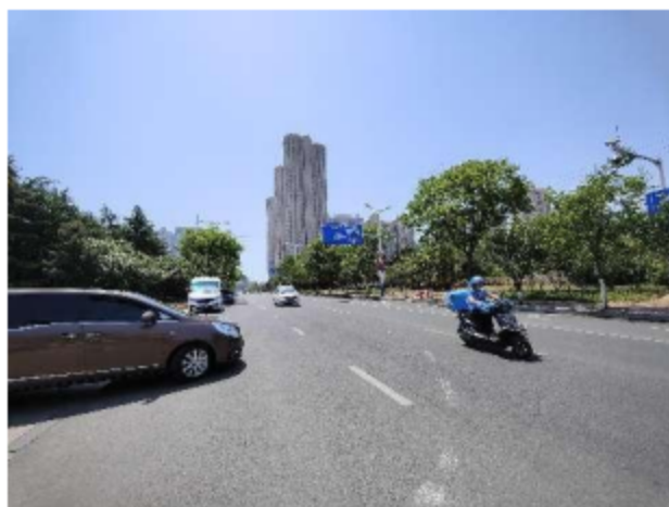
七墩山路（双向双车道）
