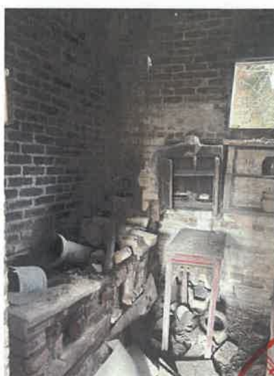
估价对象内部状况
