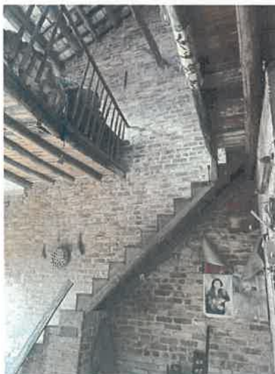
估价对象内部状况
