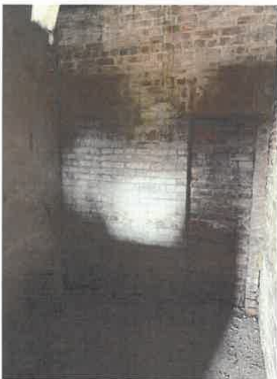
估价对象内部状况
