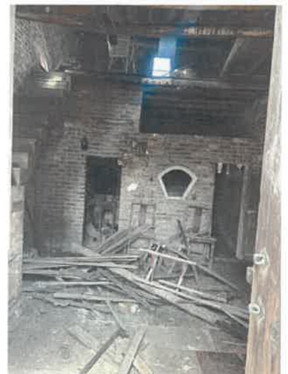
估价对象内部状况
