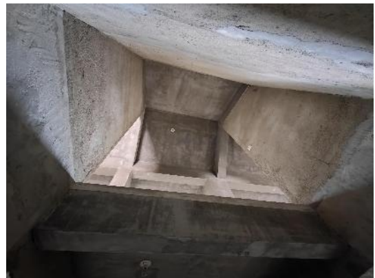
兴海北街 126-9 号 1 单元 142 室阁楼照片
