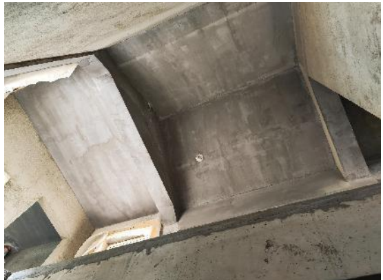
兴海北街 126-9 号 2 单元 242 室阁楼照片
