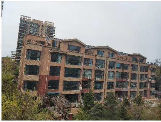
兴海北街 126-9 号 1 单元 142 室外观
