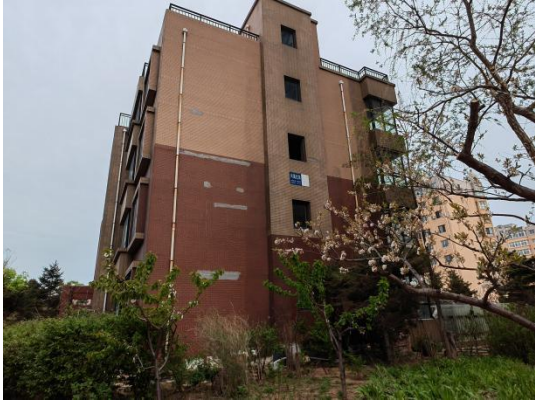
兴海北街 126-9 号 2 单元 242 室外观
