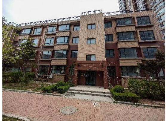
兴海北街 126-9 号 2 单元 242 室外观
