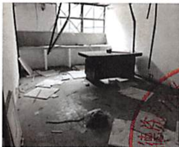
5号第一幢新仓内部1
