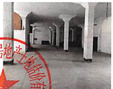
5号第一幢新仓内部2
