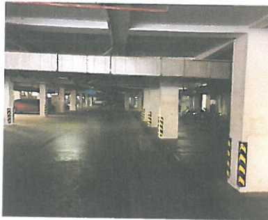
地下车库内景
