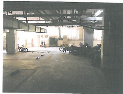
地下车库内景
