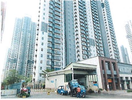
估价对象所在建筑物外观
