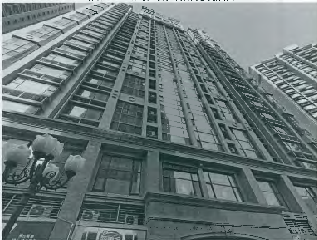
附件3 估价对象利用现状照片
