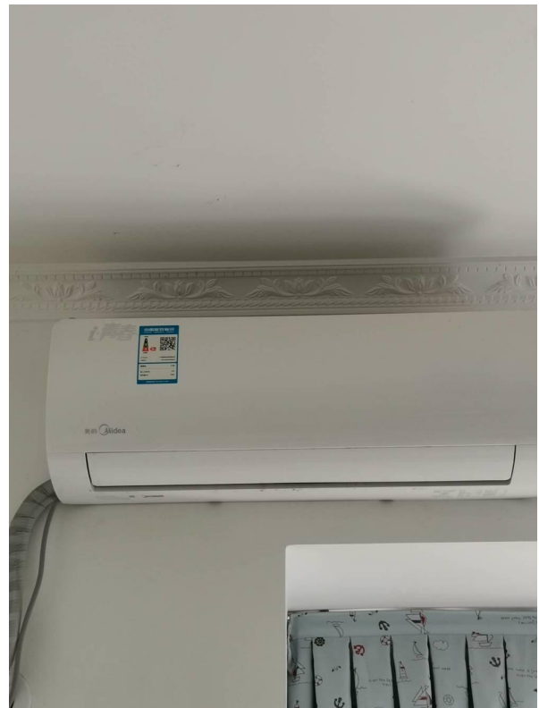
挂式空调现状
