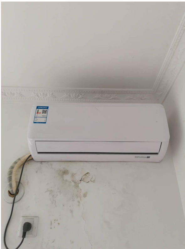
挂式空调现状
