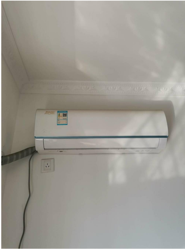
挂式空调现状
