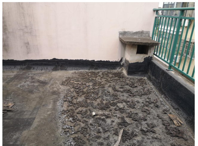
三楼室外露台
