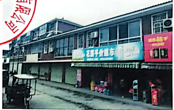
估价对象所在小区现状
