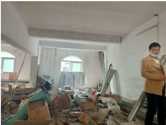
估价对象室内状况
