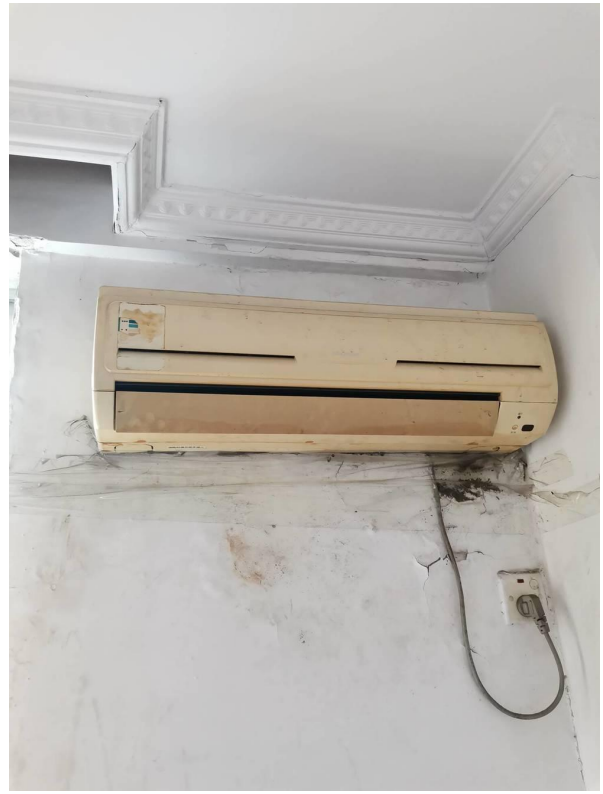
挂式空调现状
