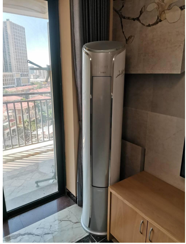
立式空调现状
