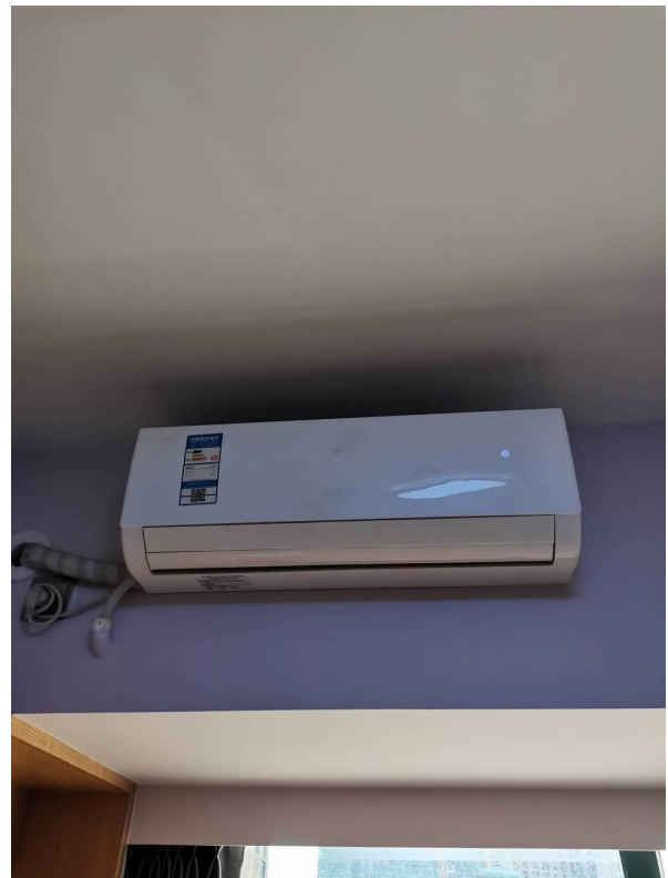
挂式空调现状
