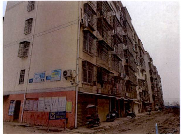
估价对象所在楼整体外观
