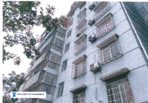
估价对象建筑物外观
