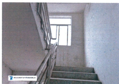
估价对象楼梯间
