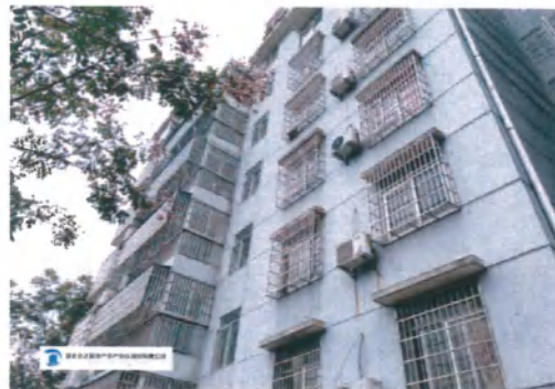
估价对象建筑物外观
