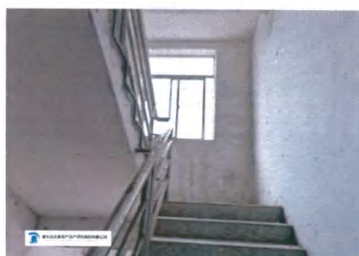
估价对象楼梯间
