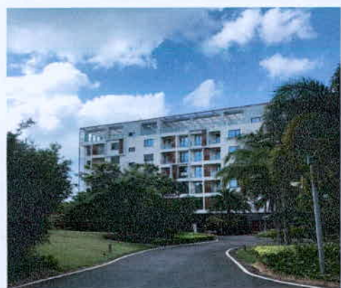
鉴定对象所在楼栋外观现状
