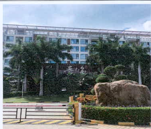
鉴定对象所在小区大门现状
