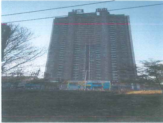
估价对象所在楼幢照片
