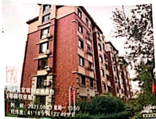
估价对象所在楼
