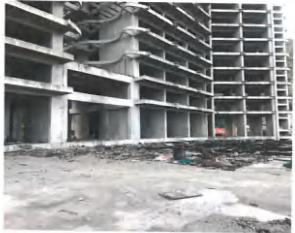
在建工程外观
