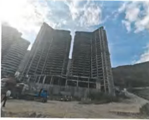
在建工程外观
