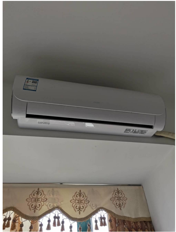
挂式空调现状
