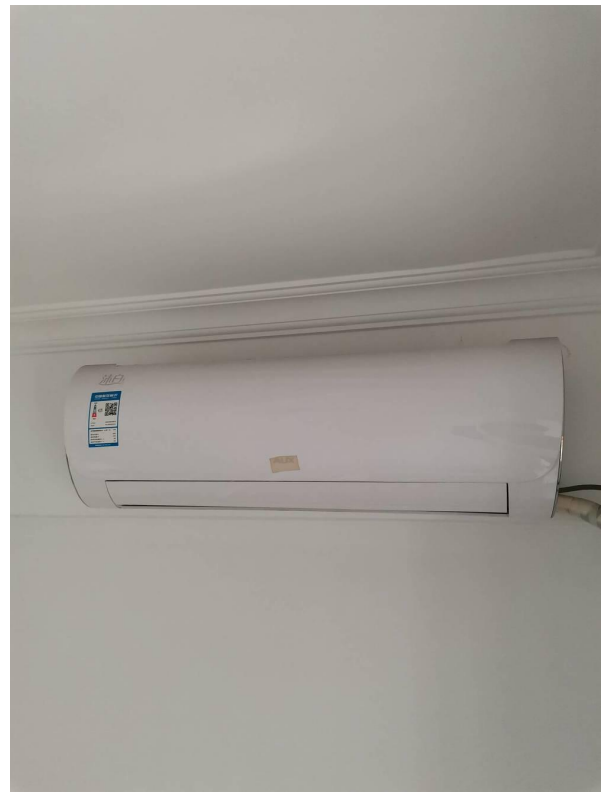
挂式空调现状
