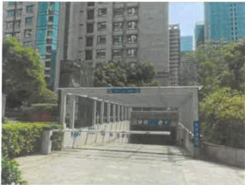
◆估价对象车库出入口
