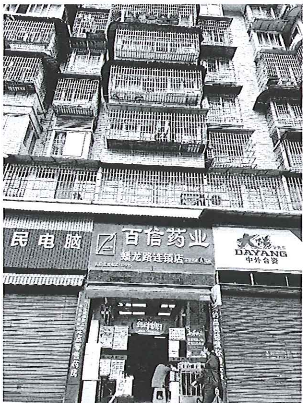
估价对象楼栋外观
