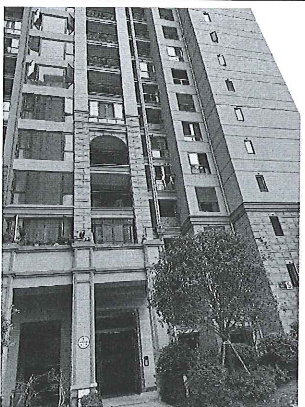
估价对象楼栋外观
