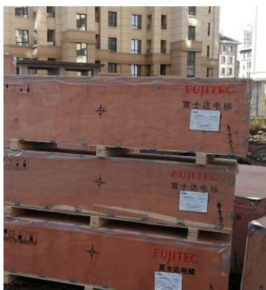
外部施工现场及待安装电梯等
