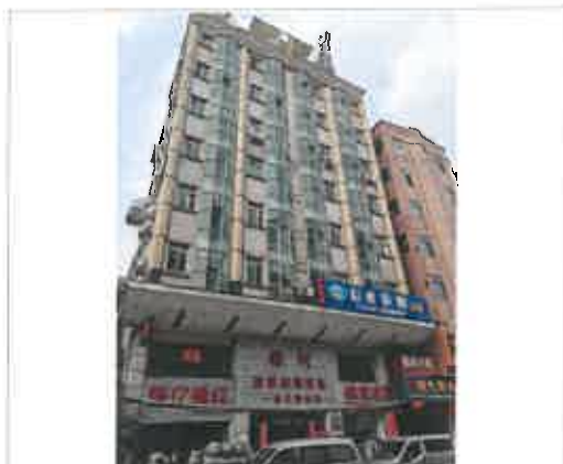
粤房地证字第 C2409741 号建筑外观
