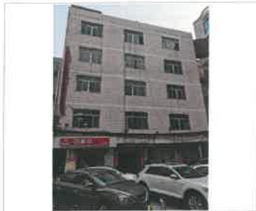
粤房地证字第 C2409760 号建筑外观
