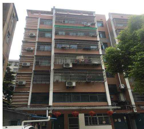
估价对象所在楼整体外观
