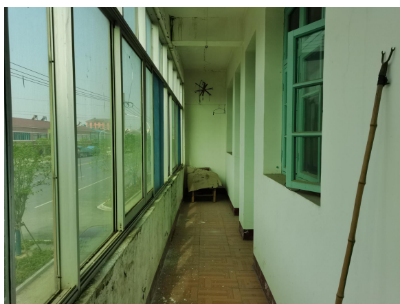
估价对象二楼阳台
