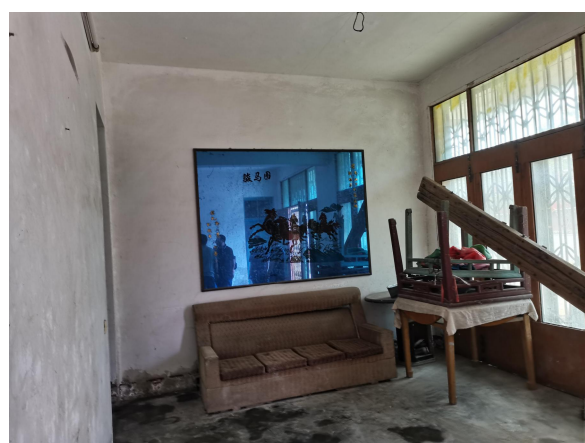
估价对象一楼客厅
