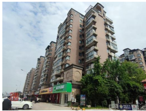
估价对象楼栋外观
