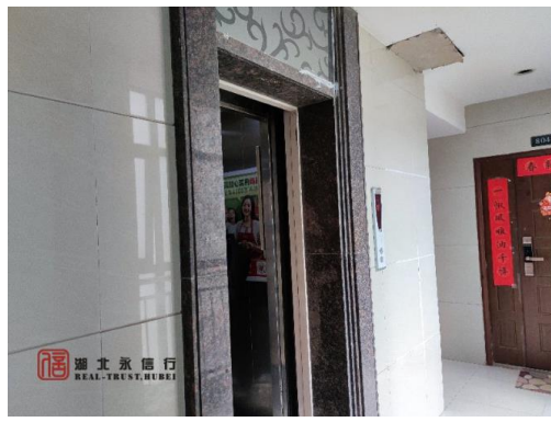
估价对象电梯
