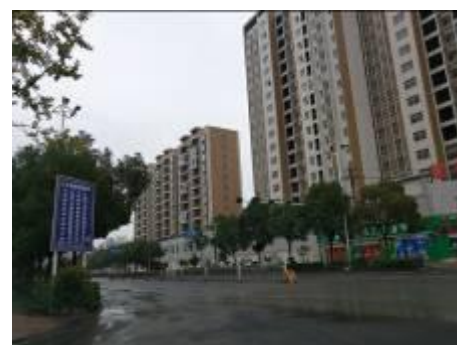
小区临路状况 2
