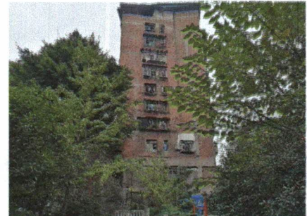
◆ 建筑外观状况
