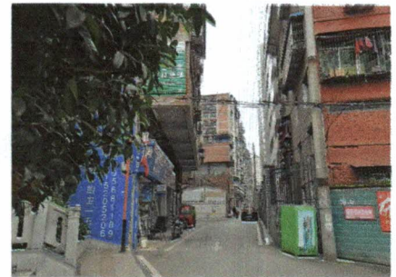
◆ 建筑第1层临街状况
