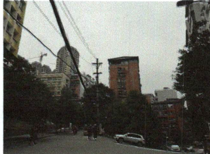
◆ 建筑外观状况
