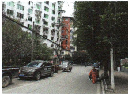
◆ 建筑临街状况
