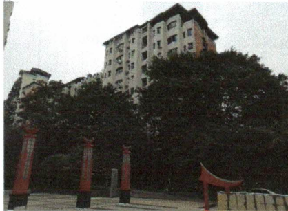
◆ 建筑外观状况
