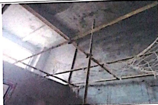
◆估价对象 2 内部状况
