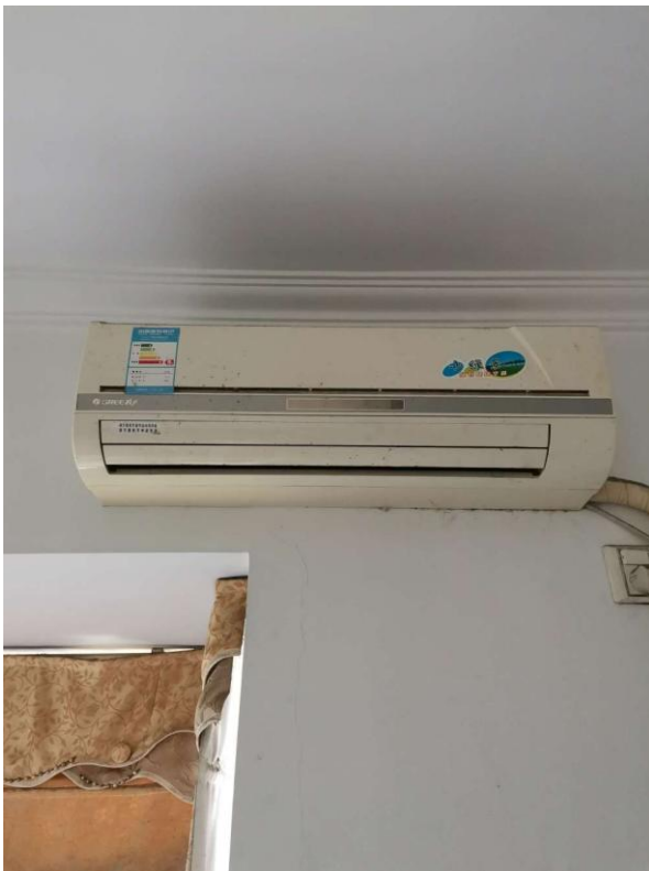
挂式空调现状
