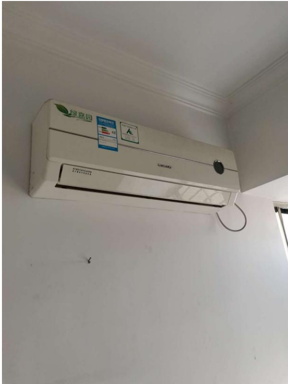
挂式空调现状
