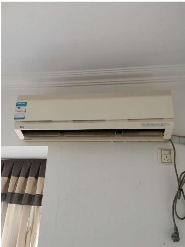
挂式空调现状
