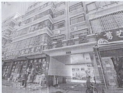
实物图 1-外部照片
