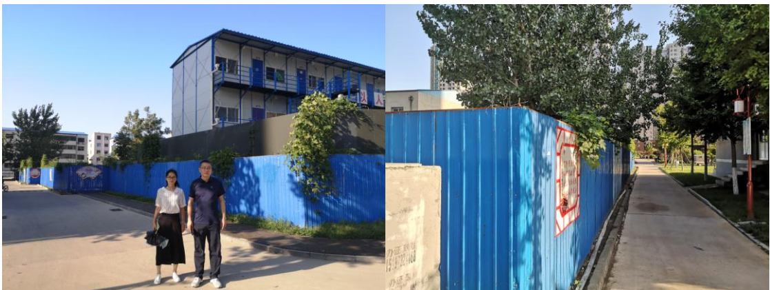
图片3-2：实例B现场查勘照片
