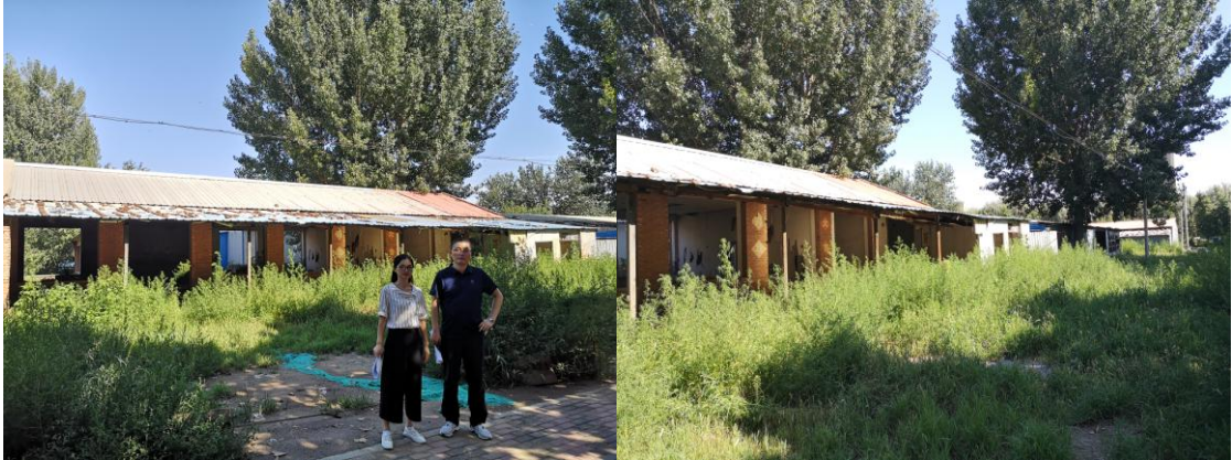
图片3-1：实例A现场查勘照片
