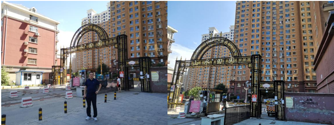
图片 3-5：实例 A 现场查勘照片
