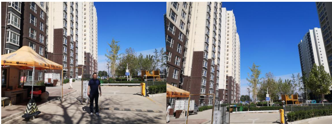
图片 3-6：实例 B 现场查勘照片
