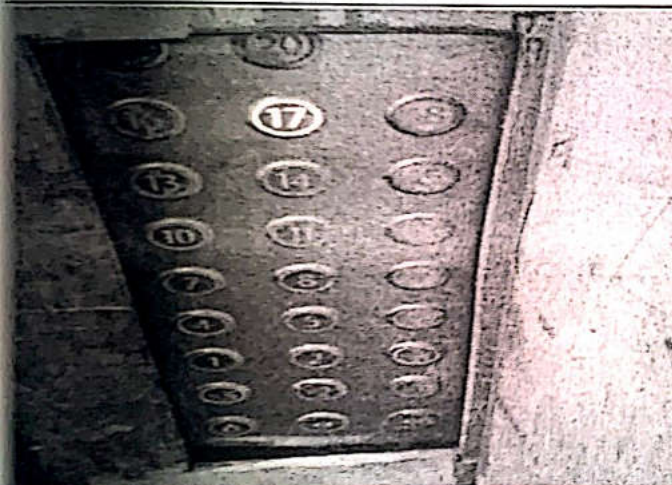
估价对象所在楼层现状
