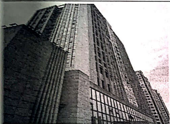
估价对象所在楼栋外观
