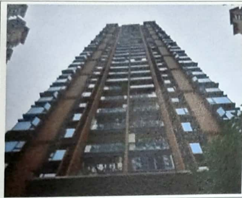
估价对象楼宇外观
