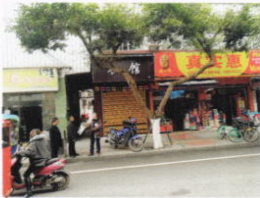
估价对象临街入口状况
