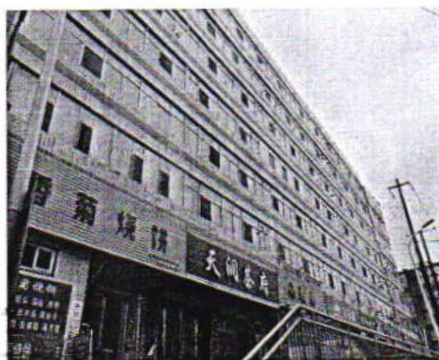
青龙路无号6幢建筑外观
