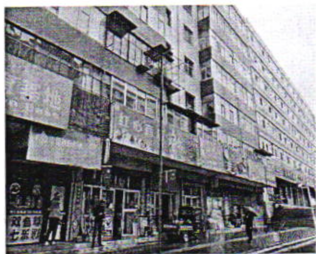
青龙路无号5幢建筑外观
