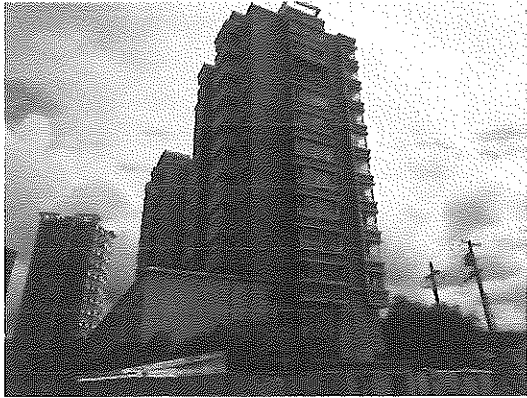
估价对象所在建筑整体外景(西侧)
