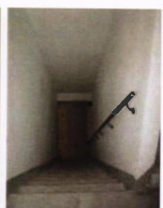
所在建筑公共楼梯
