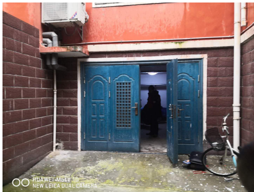
估价对象车库外观状况
