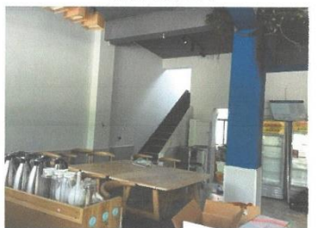
估价对象室内
