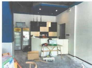
估价对象室内
