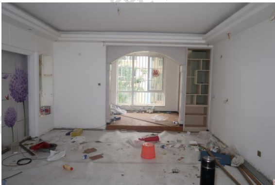
估价对象客厅及阳台
